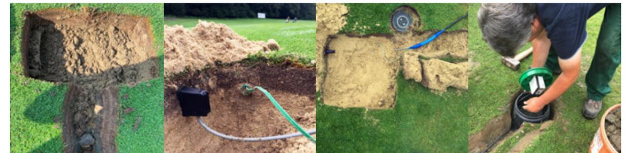
Ausstechen der Rasenziegel Verlegen der des Kabels - Einführung der Sensoren in der Hauptwurzelzone Installierung MiniMETOS SOIL: Vorbereitung der Bewässerungsbox für den Logger.
